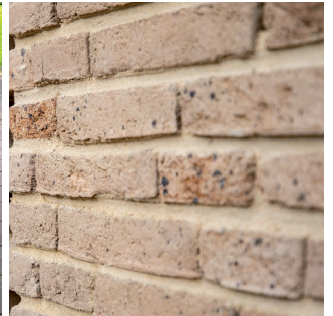
Erfmuur, meeontworpen met het gebouw
