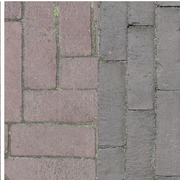
Aanduiding vakken met 3 strekken in mangaanrode kleur
