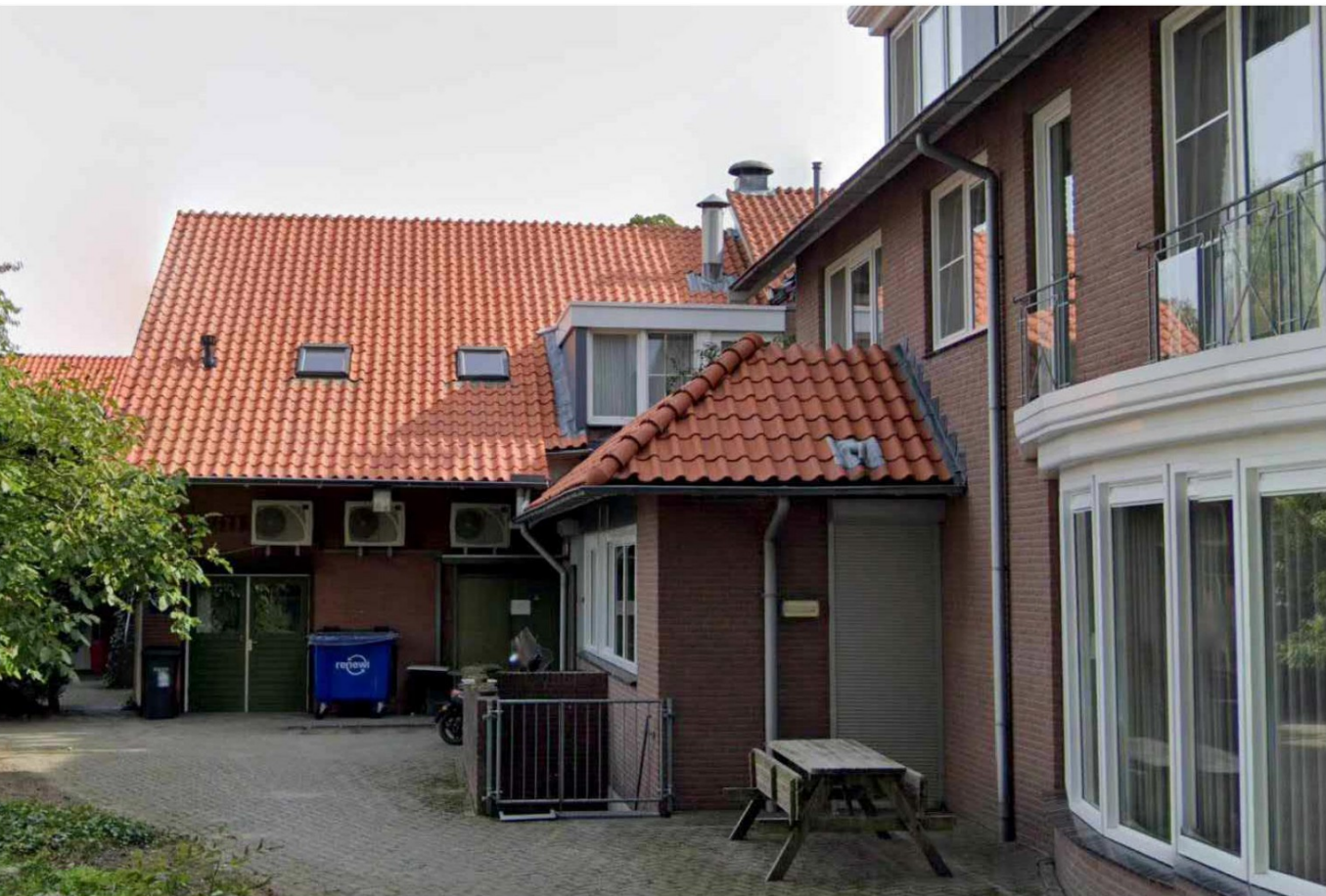
Foto - bestaande situatie
