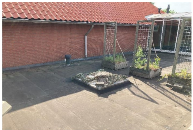
Afzuiging toilet eetzaal
